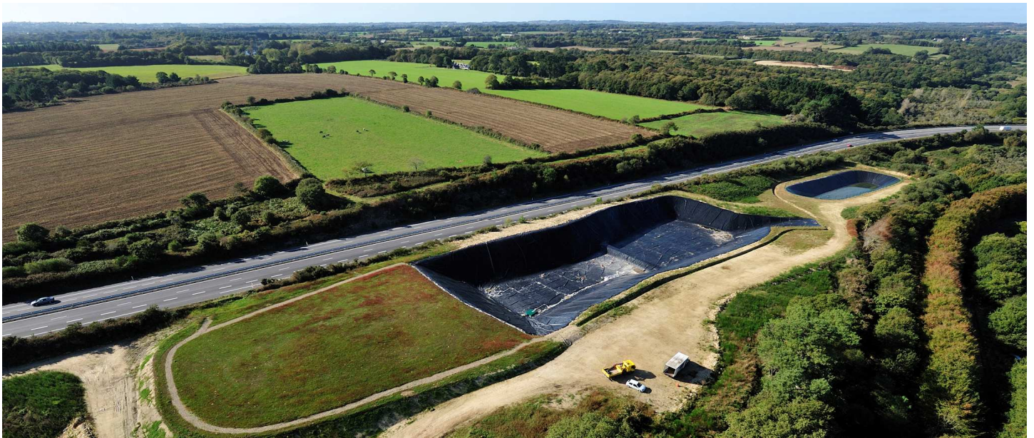
Stockage des sédiments sur le site de Ty Coq à Combrit
