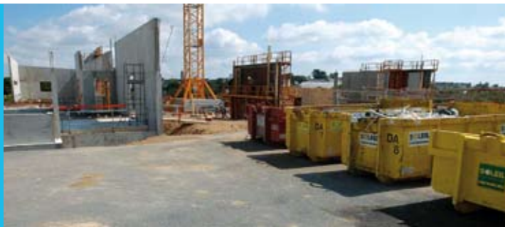
Le tri sélectif des déchets de chantier
