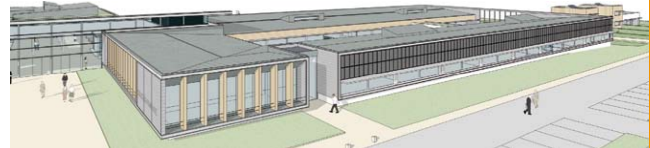
220 panneaux photovoltaïques de 60 x 120 cm installés sur la façade sud du bâtiment
